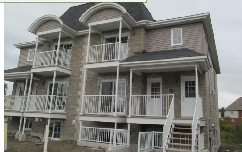
Immeuble (logement 2 chambres, 1200 pi 2 )
